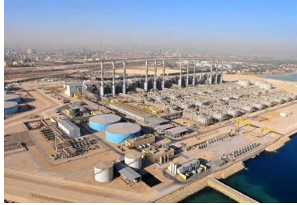
محطة الجبيل لتحلية مياه البحر مياه البحر الصورة : acciona.com
